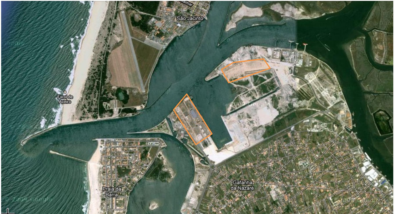
Figura 1 – Porto de Aveiro: Terminal Polivalente e Terminal Granéis Sólidos
