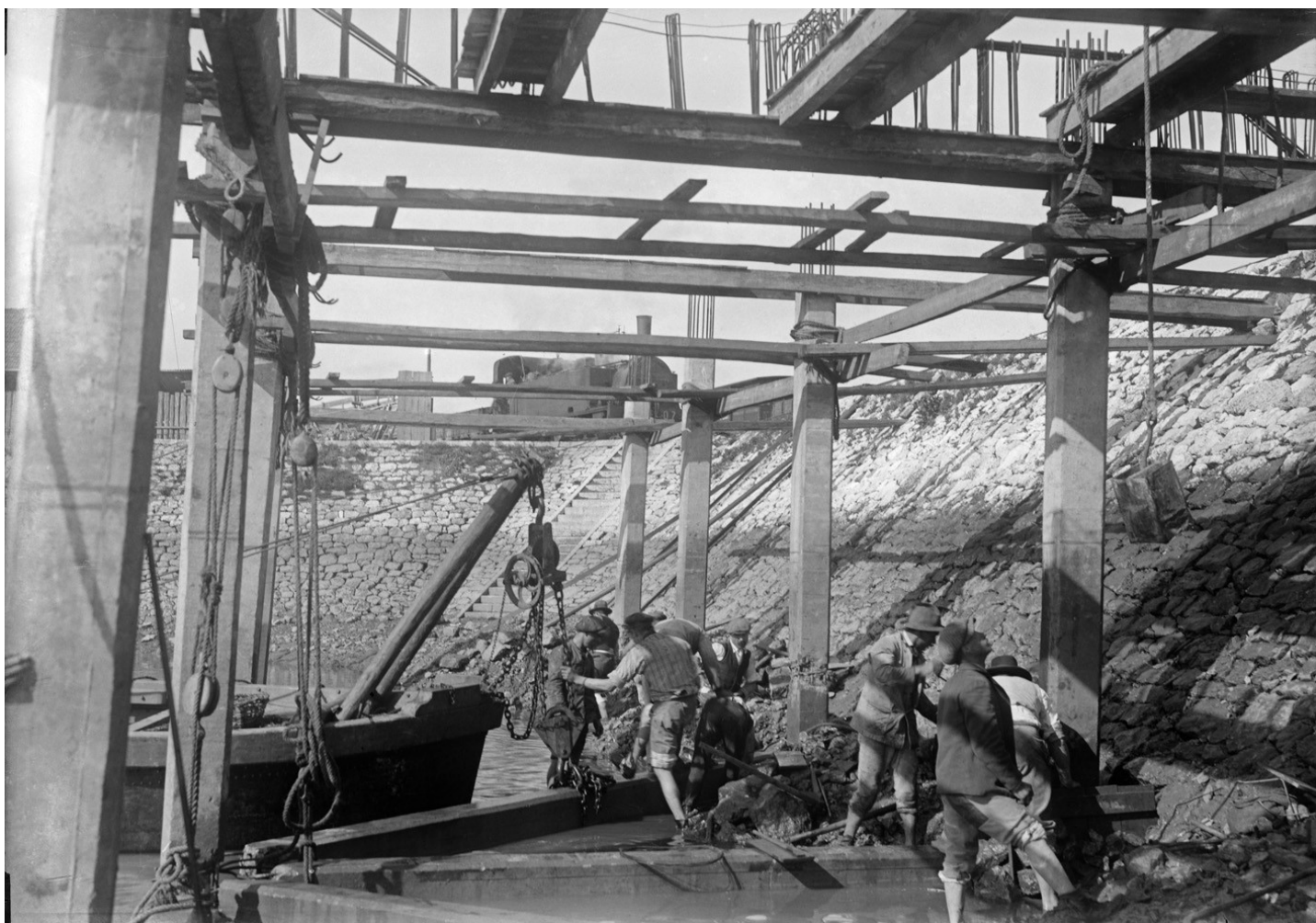
Construção do cais acostável na doca de Santo Amaro
