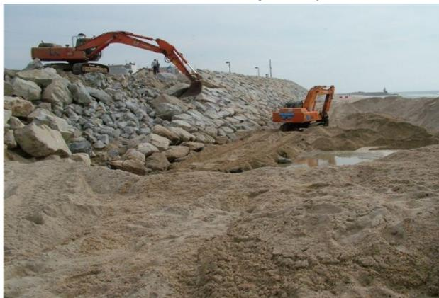
Escavação para execução da banquetta e colocação de enrocamento no talude de defesa aderente
