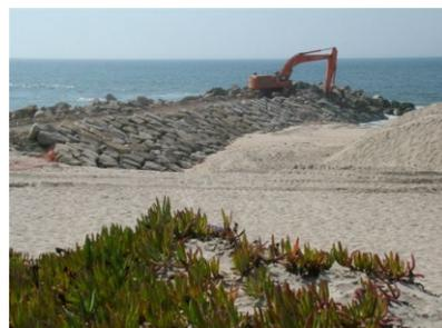
Execução do enrocamento no talude do esporão norte
