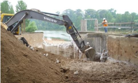
Canal de Jusante - Zona de trabalhos de demolição do muro de suporte e da escada existente (2010-07-01).
