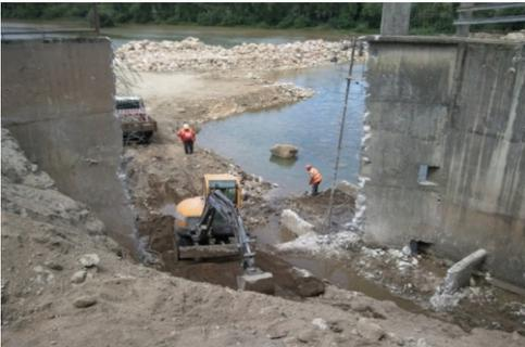
Obra de Jusante - Demolição do muro de suporte e da escada existente (2010 - 07 - 14)
