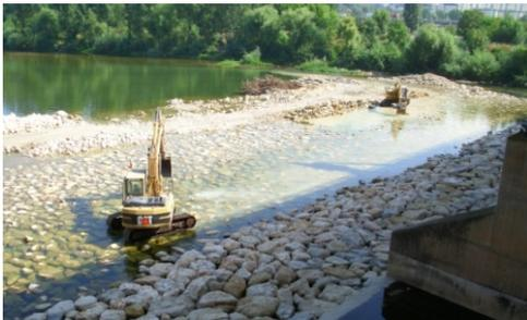
Jusante do Açude. Aplicação do enrocamento no tapete de protecção (2010 - 07 - 20)
