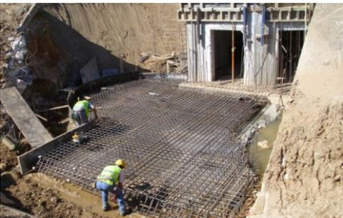
Obra de Montante - Saída do peixe. Montagem das armaduras da lage térrea (2010 - 07 - 15)
