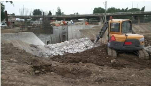
Saída da Escada - Obra de Montante. Demolição da lage de protecção do talude (2010 - 07 - 07)
