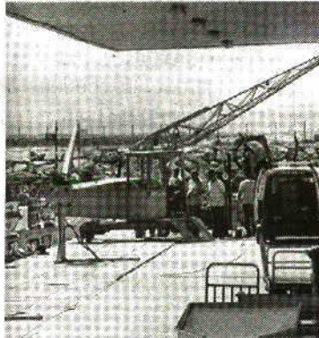
Grua está a ser reparada
