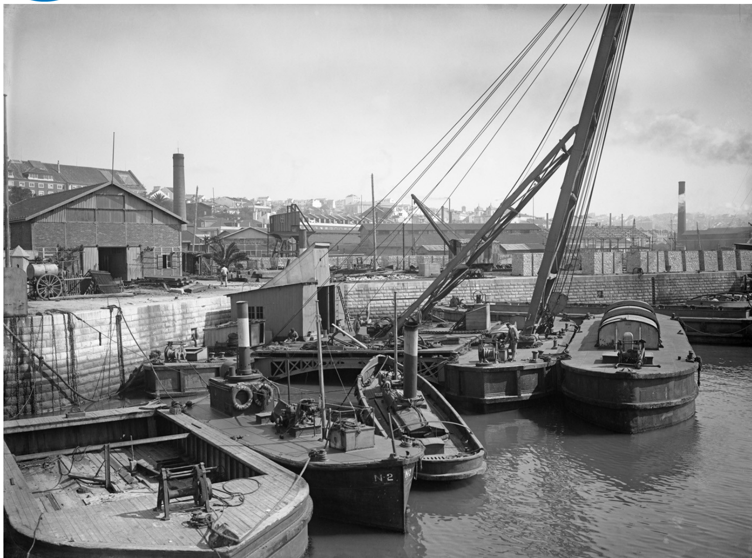
Cais da eclusa e oficina das pequenas reparações da Exploração do Porto de Lisboa
