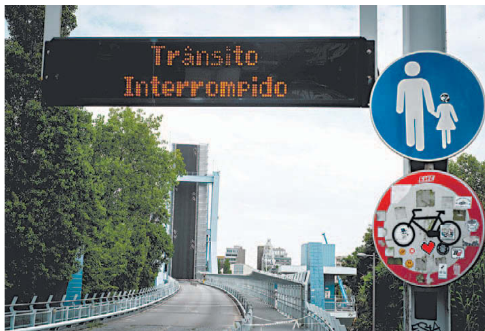
Desde que foi construída, a ponte avariou pelo menos três vezes
