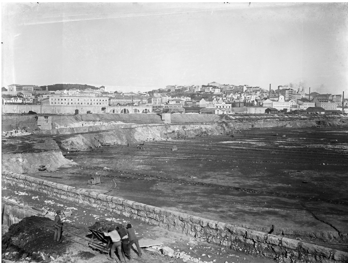
Construção da Doca de Alcântara
