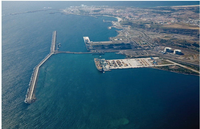
Vista aérea da primeira fase de expansão do Terminal XXI
